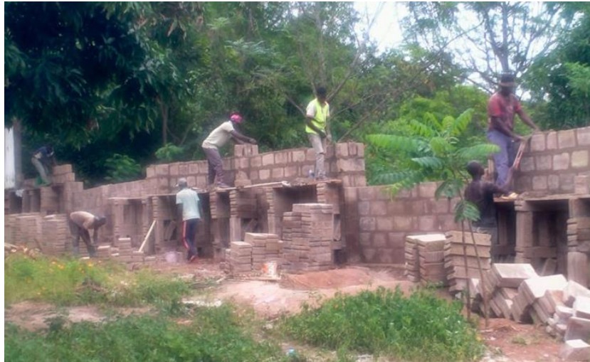
De bouw van de omheining rond Malimbe Family
